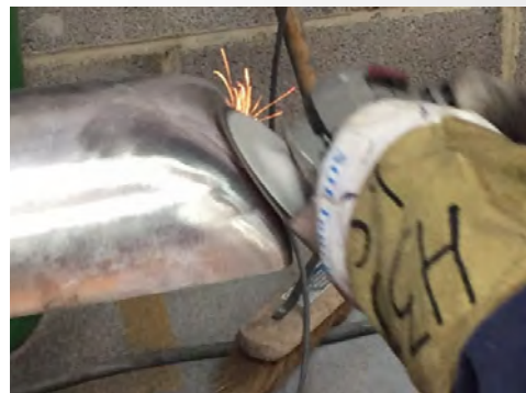
Usunięcie spoiny, wykończenie całej powierzchni
